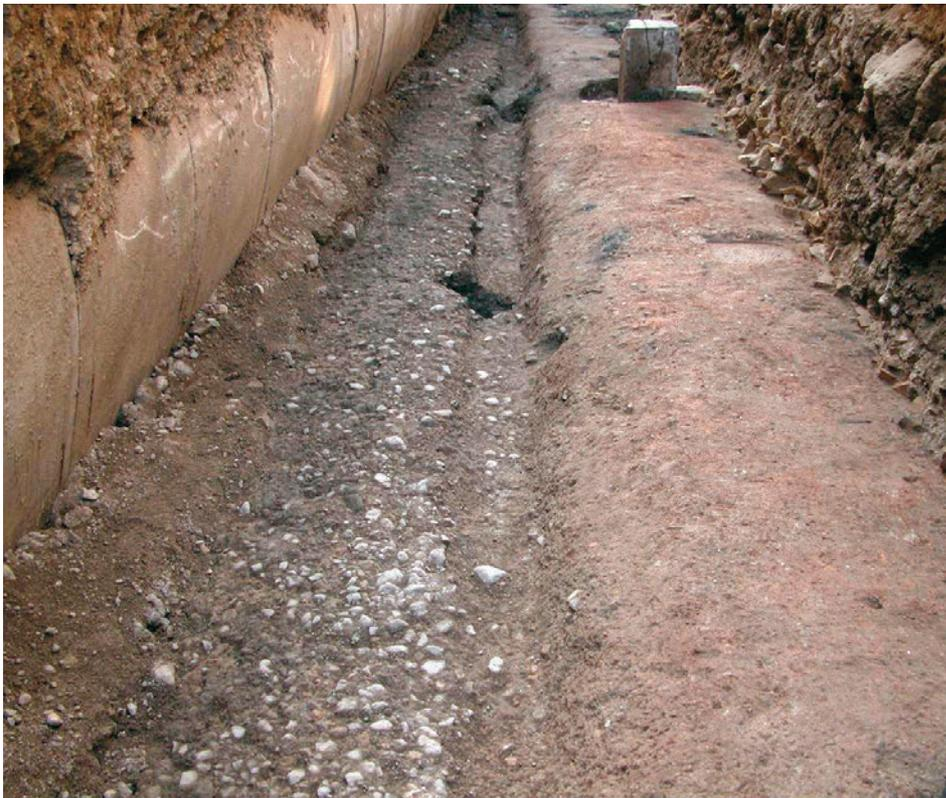
Fig. 12. Riva del Garda, via Roma. Particolare del marciapiede in battuto di terra della via glareata; sullo sfondo si può vedere uno dei pilastri del portico.
